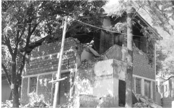
شکل 7.1: زلزلے سے تباہ ایک عمارت
