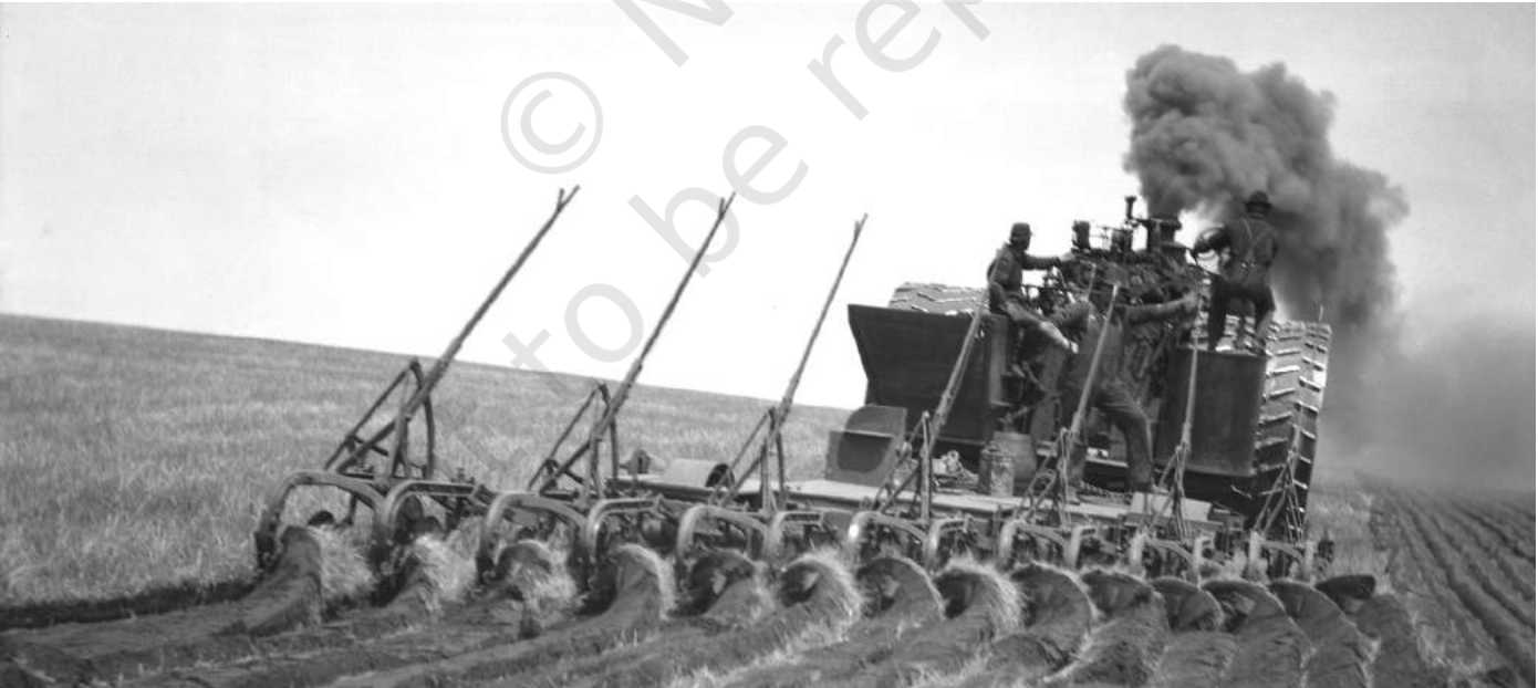
شکل 15۔ شمالی ڈکوٹا میں عظیم میدانوں کی زمین ہموار کرتے ہوئے، 1910: آپ دھات کی پھالیوں کے ساتھ جان ڈیر کے ہل کو کھینچتے ہوئے منی پالس اسٹیم ٹریکٹر دیکھ سکتے ہیں جو (پھالیاں) زمین میں گھس کر مٹی کو ختم ریزی کے قابل بناتی ہیں یہ ہل مٹی کو بڑی تیزی سے توڑ سکتا تھا اور گھاس کی سخت جڑوں کو بھی بڑی کامیابی سے اکھاڑ سکتا تھا۔ مشین کے پیچھے بانیں جانب کوڑوں (Furrows) اور گھاس بھری بغیر ہل چلائی زمین پر نظر ڈالئے۔ صرف بڑے کسان ہی ان مشینوں کا خرچ برداشت کر سکتے تھے۔
