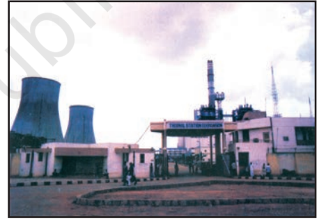
شکل 3.9 : حرارتی بجلی گھر کا ایک منظر
