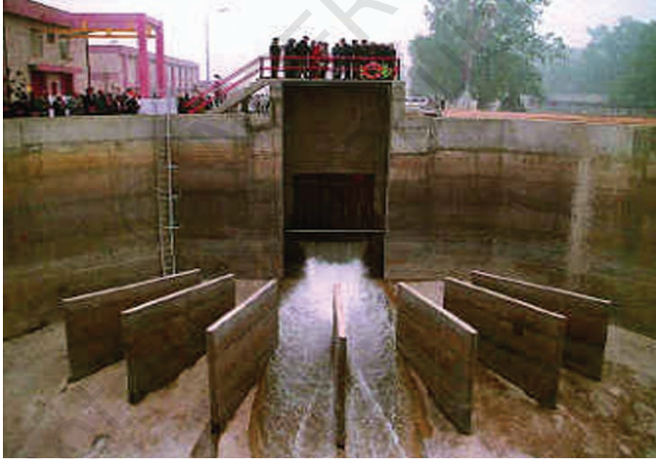
شکل 18.10 : واٹر ٹریٹمنٹ پلانٹ
