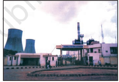
شکل 3.9 : حرارتی بجلی گھر کا ایک منظر
